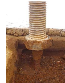
ボルト基部の腐食
