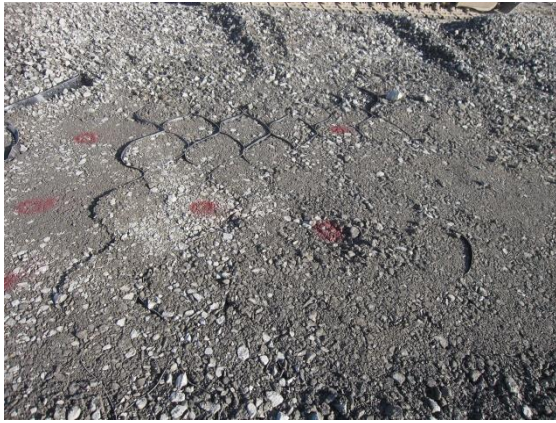
(c) 締固め後の中詰め材の状況(タイプ B)
