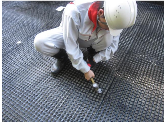
(f) 固定杭によるジオグリッドの固定
