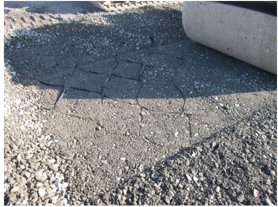
(d) 締固め後の中詰め材の状況(タイプ C)
