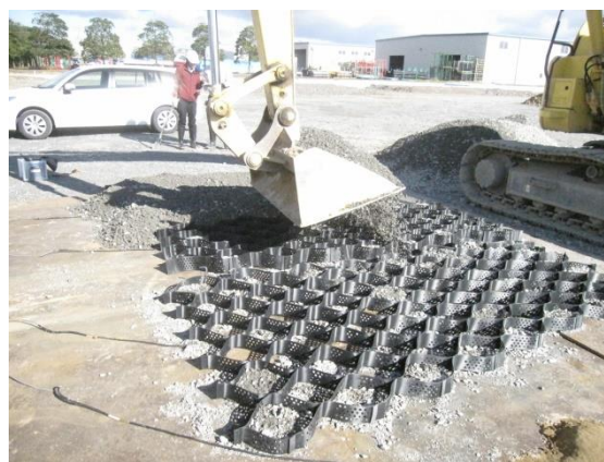
(b) 碎石の投入
