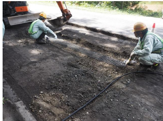
(b) 水分センサーの設置
