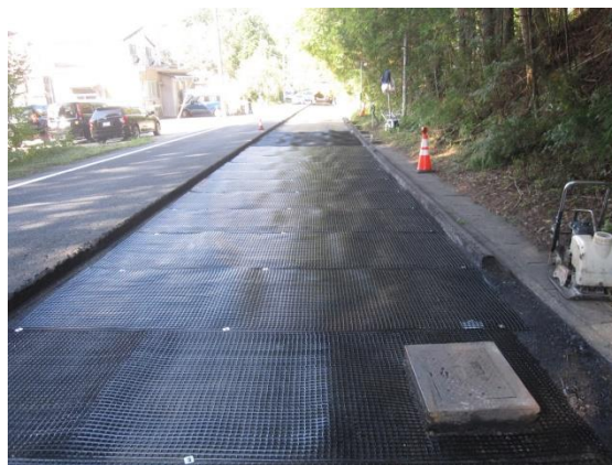
(d) ジオグリッドの敷設 (直線区間)
