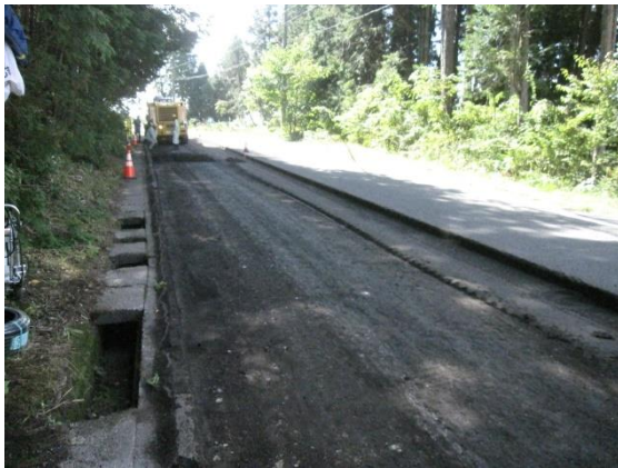
(a) 路盤の掘削
