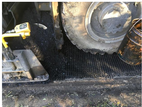
(f) 瀝青安定処理混合物のまき出し
