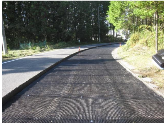
(e) ジオグリッドの敷設 (曲線区間)
