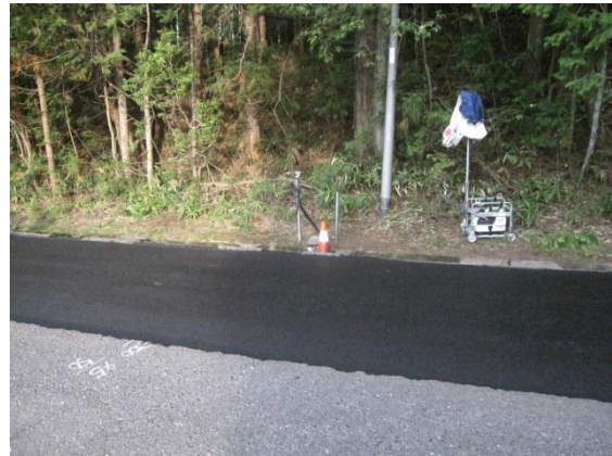
(d) 上層路盤の補修
