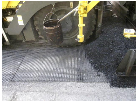
(b) 瀝青安定処理混合物のまき出し(2) (ジオグリッドを重ねて設置した箇所)
