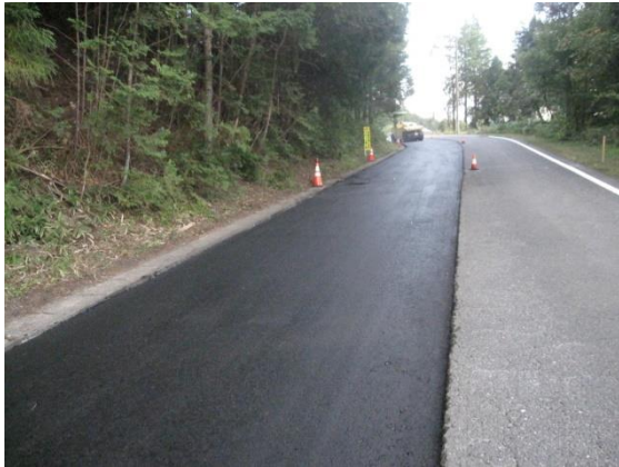
(e) 完成状況（直線区間）
