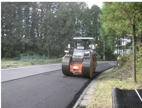
(c) 振動ローラーによる転圧
