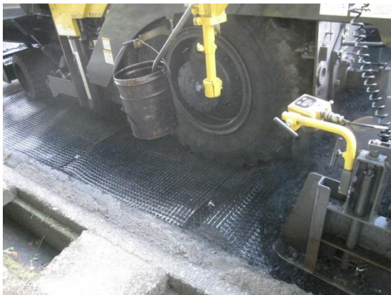
(a) 瀝青安定処理混合物のまき出し(1) (ジオグリッドをつき合わせて設置した箇所)
