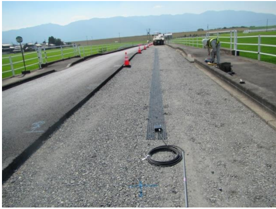
(a) ジオグリッドセンサーの敷設状況
