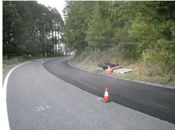
(f) 完成状況（曲線区間）
