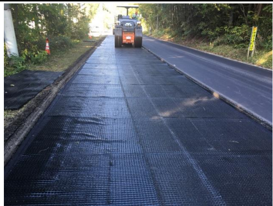
(b) 振動ローラーによる転圧
