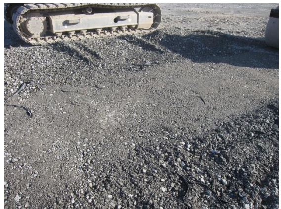
(b) 締固め後の中詰め材の状況(タイプ A)
