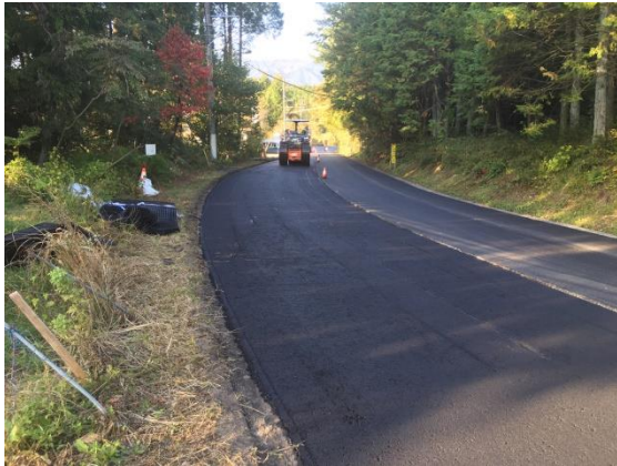
(a) 振動ローラーによる転圧
