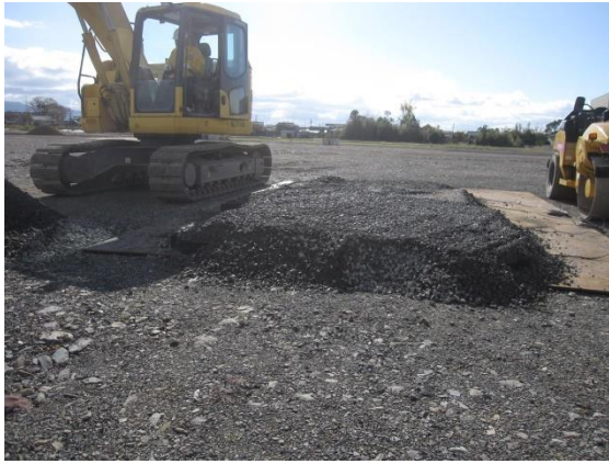
(c) 碎石のまき出し後の状況
