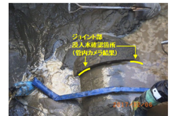
空洞の開削調査 合流管(Φ800, GL-1.64m)
