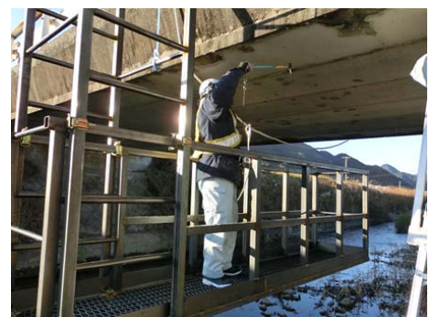
写真 1.3 打音検査の状況
