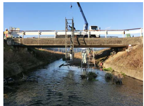
写真 1.2 実橋での設置状況
