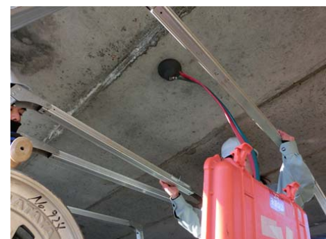
写真 1.4 透気試験の状況
