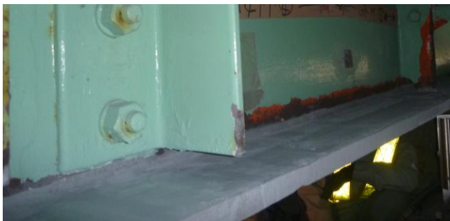
図12 施工後の下フランジ状況
