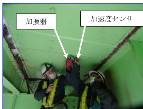
写真-5.2 床版下面からの測定状況
