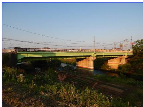
写真-5.1 対象橋梁
