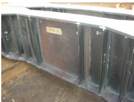
実腐食ウェブ試験体
