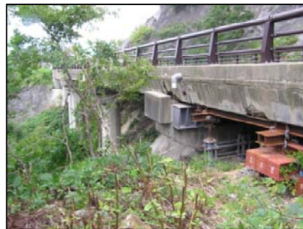
緊急応急対策 『主桁仮受けベント の設置状況』
