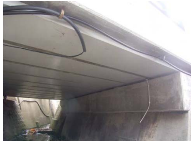
補修工事(上部工の架替工事)後の状況
