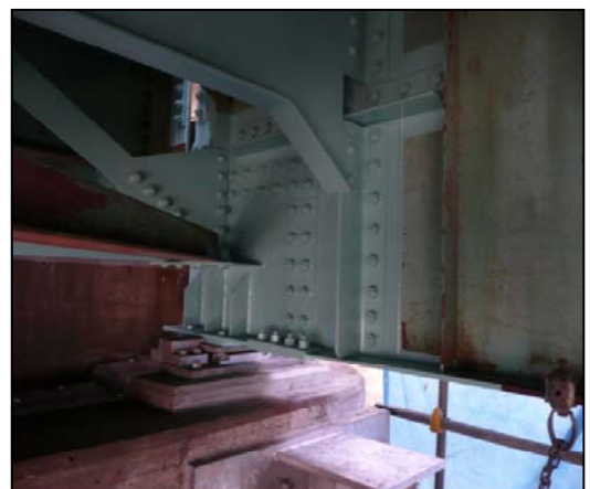
あて板による補修
