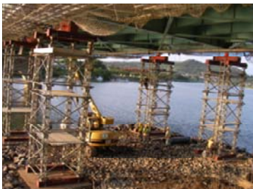
河川内に築島した上で支保工による仮受け
