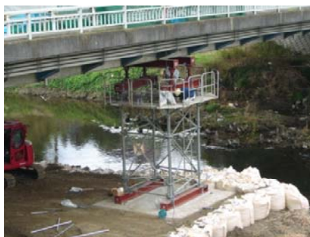
支保工による仮受け
