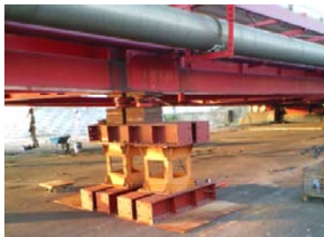
支保工による仮受け
