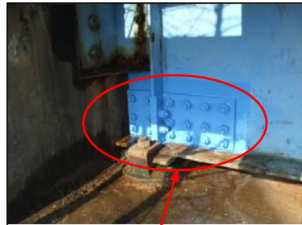
あて板による桁補修
