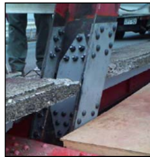
あて板による補修
