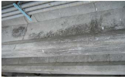
※写真はPC桁下面のひびわれ事例
