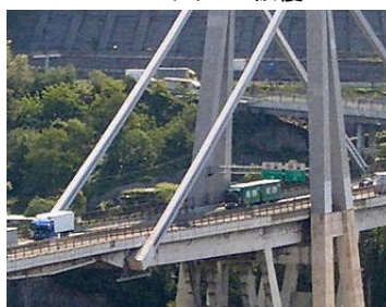
コンクリート被覆
