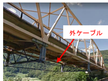
鋼橋の外ケーブル補強の例
