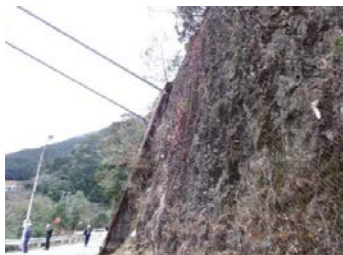
ワイヤークリップによる端末処理
