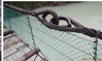
主ケーブルがロッドに定着されている例
