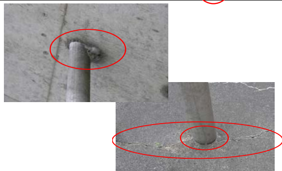
内部の腐食を疑わせる変状
