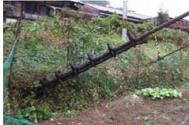
ワイヤークリップによる端末処理
