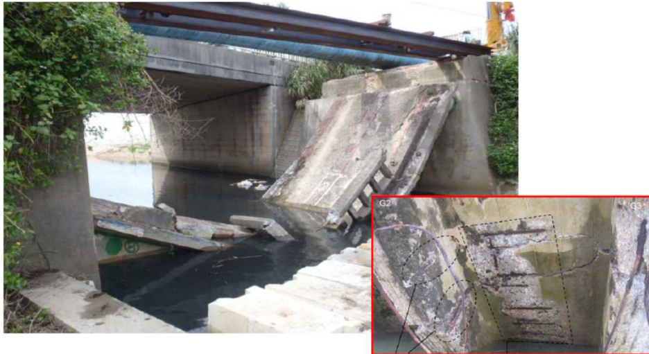
写真 2-1 老朽化が原因で落橋した国内事例
