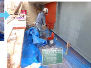
【防錆塗料1回目】
