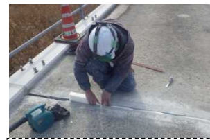
①既設撤去⇒清掃⇒不陸修正⇒バックアップ材挿入⇒プライマー塗布
