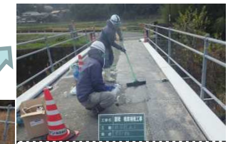
④常温型塗膜防水塗布⇒保護骨材(珪砂)散布
