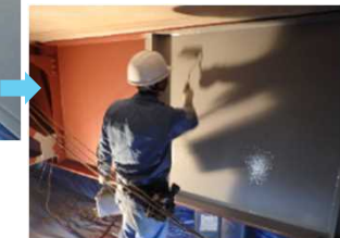
【防錆塗料2回目】
