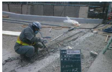
①箱抜きによる床版のはつり
