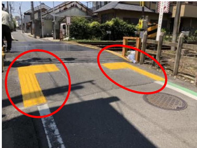
写真 2-7-● 視覚障害者誘導用ブロックを車道上に設置した事例 （令和6年〇月の本ガイドライン改定前に設置した事例）
