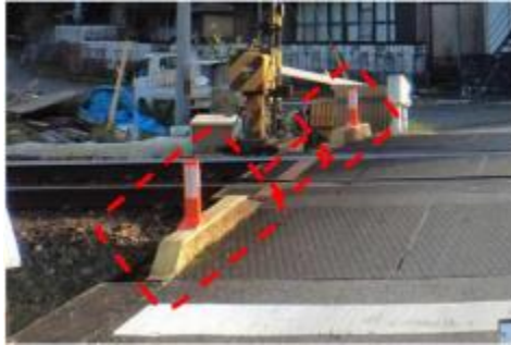
写真 2-7-● 踏切道端部のブロック、ラバーポール及び路面標示の設置事例
