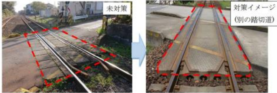
写真 2-7-● 踏切道内の平滑化イメージ
