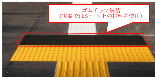
写真 ● 評価実験で実施したゴムチップ舗装
