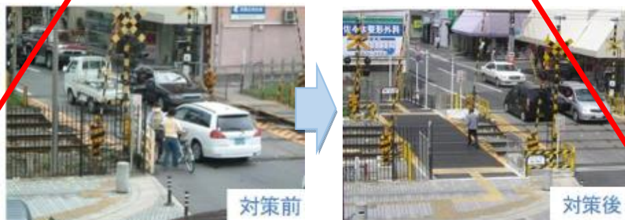
写真 2-1-26 踏切拡幅（歩道新設）の例
