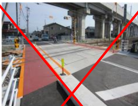
写真 2-1-28 カラー舗装の例
