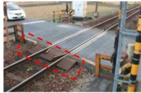
写真 2-7-● スロープの設置事例
