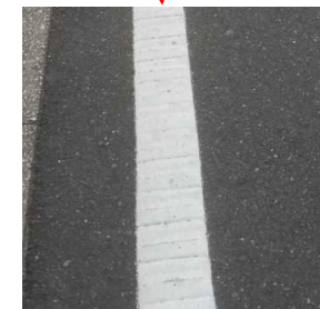
ランブルストリップス(舗装表面を一定 間隔に切削し、溝を配置したもの) による視覚障害者の誘導
