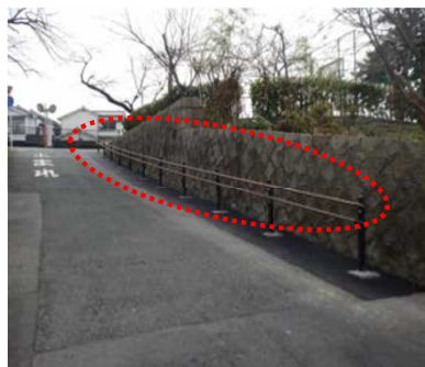
坂道への手すりの設置
