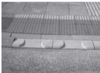
車椅子、ベビーカーが通りやすい ように段差を一部解消した縁石
