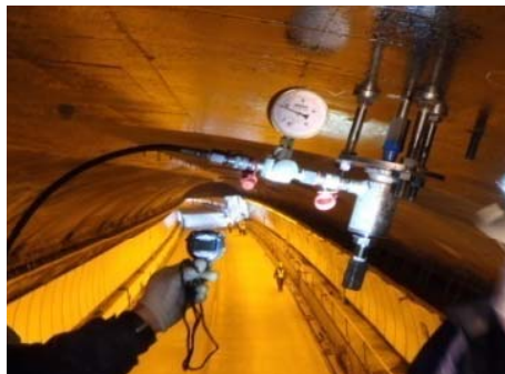
引抜き試験写真
