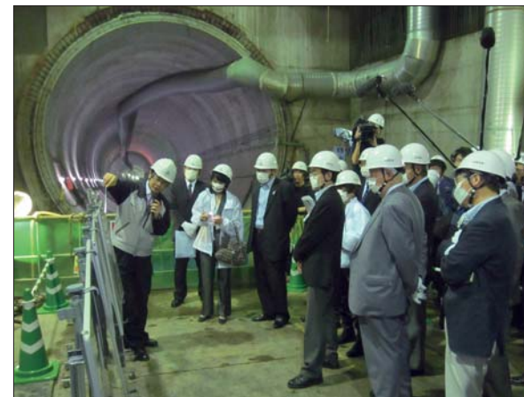
視察状況 (大橋 JCT)
