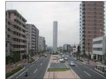
■ 中央環状新宿線山手トンネル換気塔 ■
