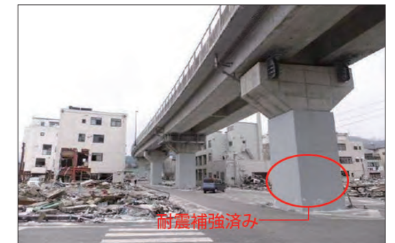
東日本大震災の地震動による損傷なし (国道45号)
