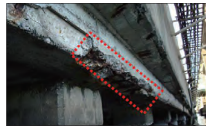
コンクリートの剥落
