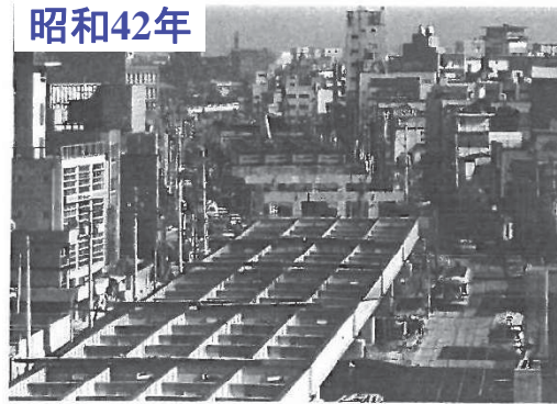
首都高速道路建設工事 [1967年1月16日] 橋桁建設中
