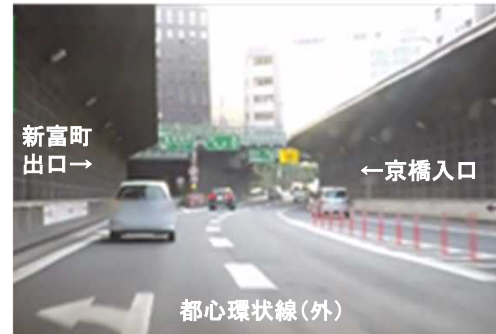
京橋入口合流・新富町出口分流付近
