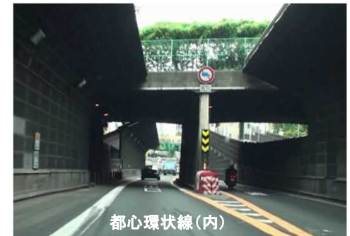
車道内橋脚(新富橋)
