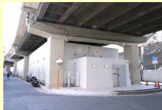
【トランクルーム：首都高速道路高架下（東京都）】
