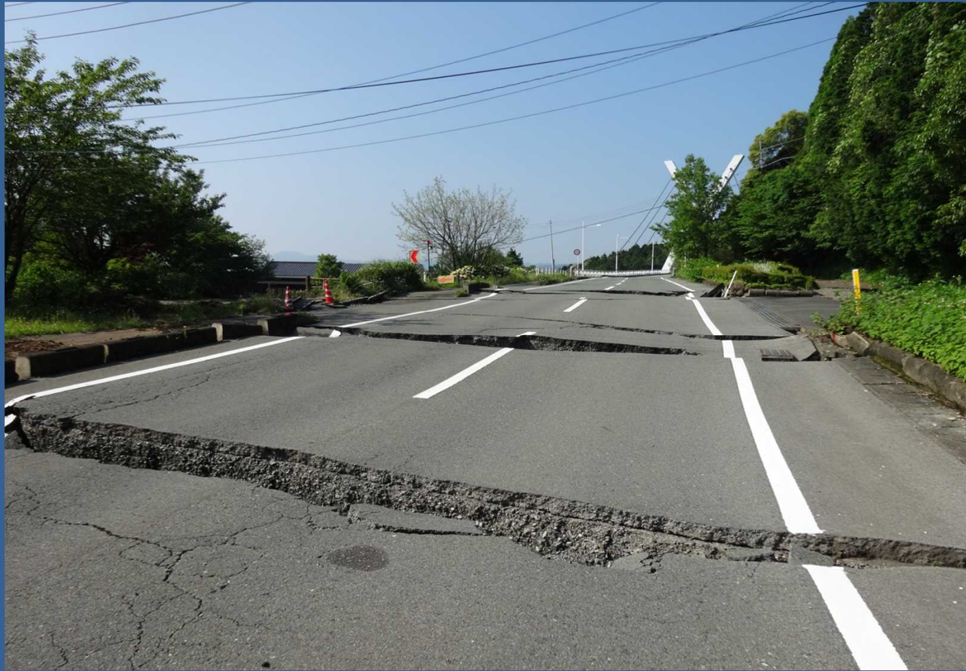
県道28号熊本高森線 桑鶴大橋付近
