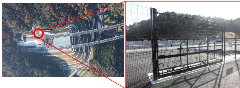
<緊急開口部設置の状況(新名神高速道路 箕面とどろみIC~茨城千提寺IC)>
