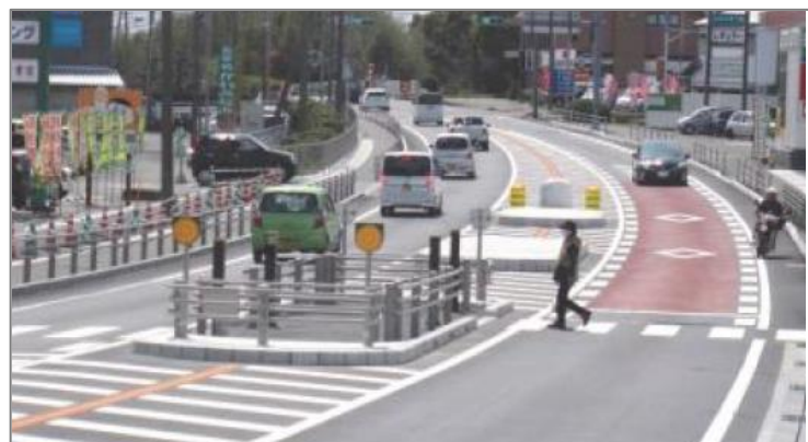
▲二段階横断施設(国道10号宮崎県川南町平田地区)
