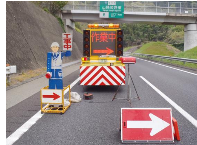
工事、車線規制情報
