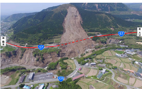
【H28熊本地震】国道57号、国道325号 阿蘇大橋地区 (熊本県阿蘇郡南阿蘇村)
