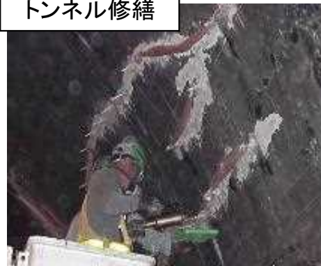
ひび割れ注入による補修
