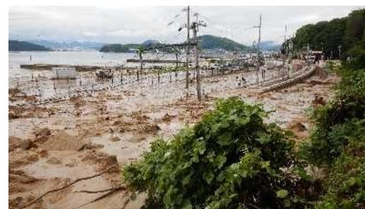
【H30.7月豪雨】国道31号 道路区域外からの流木・土砂等の流入(広島県安芸郡坂町)
