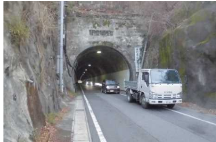
<仁方隧道の状況>
