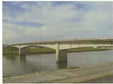
<天大橋の状況>
