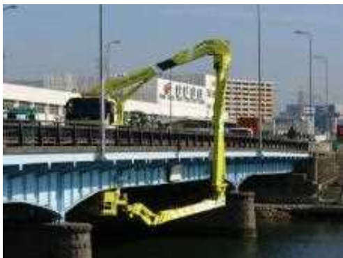
橋梁定期点検
