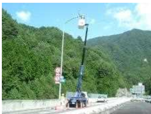
附属物点検（道路照明）
