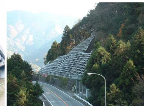
斜面崩落防止対策
