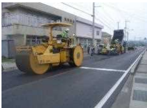
切削オーバーレイによる補修
