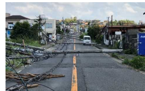
【H30台風第21号】電柱横転(大阪府泉南市) 6
