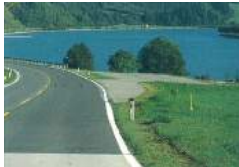
写真 5.8.2 オーバールックを設置して、地域の眺望を道路に取り込んでいる。
