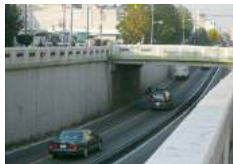
写真 5.7.6 側壁コンクリートの無駄な細工を省き、天端部のシンプルなデザインで統一感と連続性を確保している。擁壁面天端の着色笠木と防護柵のラインを横断橋梁部にも連続させている。
