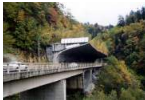
写真 5.4.10 片持ち式で内部、外部景観ともすっきりと自然におさめている。入口上部に後付けされた雪庇防止板に工夫が望まれる。
