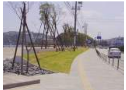
写真 5.5.25 海沿いの道路の歩道部と護岸とを一体にデザインした魅力的なプロムナード。素材の選択と細部のおさまりが吟味されている。
