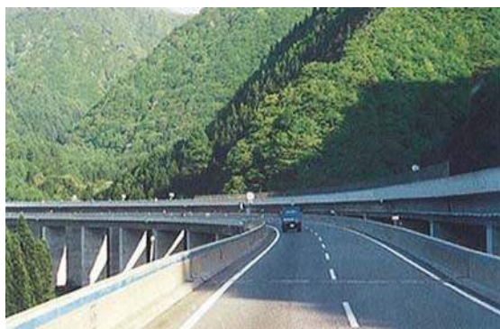
写真 5.3.10 11 地形に沿った線形設定と高架構造の採用によって切盛土を少なくし、自然環境への影響を低減して景観的効果をあげている。
