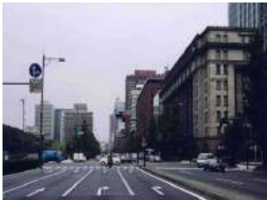
写真 4.4.5 車が中心の道路。写真では分かりにくいですが、歩道部も広く、歩行者も移動上の違和感は少ない。
