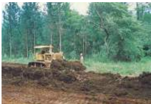
写真 1.9 工事に先立って、道路敷内の表土を剥ぎ取っている。
