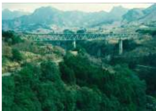
写真 5.3.56 山岳部の豊かな自然景観を重視したい場合などに、控え目な存在感とすることが可能なトラス橋。桁橋等と比べて細い部材により透過性があるので、色彩を選べば存在感を弱められる。
