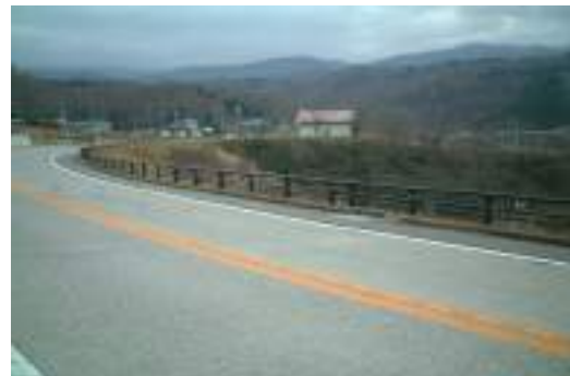
写真 5.10.2 安定感のある構造と吟味された色彩を採用した防護柵は、違和感なく景観に馴染んでいる。
