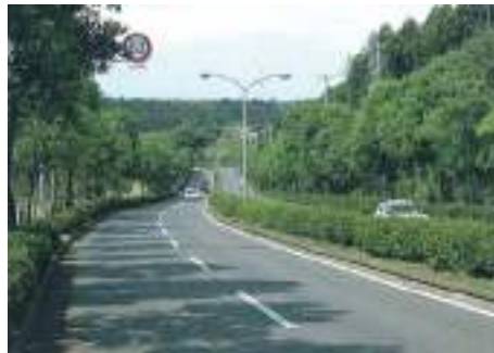
写真 5.5.48 柔らかな印象のナンキンハゼの並木で沿道の自然環境との調和を図り、単一樹種の低木を中央分離帯に植栽してシンプルで機能的な走行空間を確保している。
