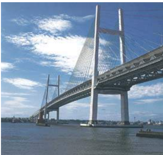
写真 3.3.1 橋梁が都市のランドマークとなり迫力のある海辺の景観をつくりだしている。
