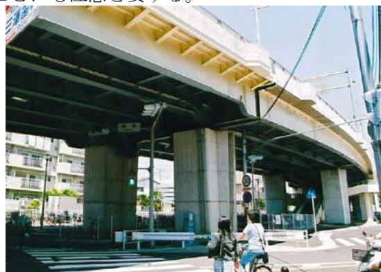
写真 5.3.4-12 市街地に建設される高架橋には様々な制約が生じる。ここでは、橋脚設置位置の制約から、桁高も床版形式も異なる構造が隣り合わせに採用された。それに対して、フェイスラインの高さを揃えるなど、連続性に配慮したデザインがなされ、市街地景観に統一感を与えている。
