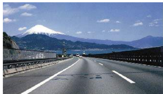
写真 2.1.1 完成後の東名高速道路上り線・由比P A付近の走行写真
