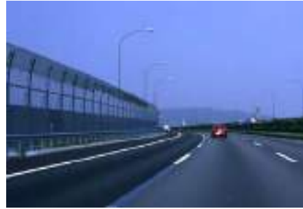
写真 5.10.4 天端の枠を取り除いた透光板の遮音壁によって、道路内・外部景観において圧迫感を少なくしている。
