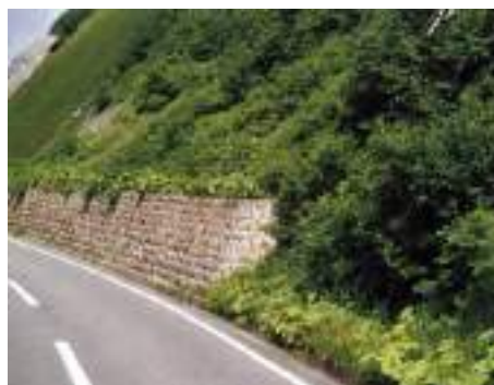
エイジング効果の現れた石積み擁壁
