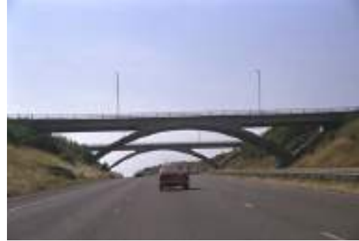
写真 5.3.1417 二つの跨道橋の線形と構造形式を揃えることによって、印象的なダブルシルエットが実現している。
