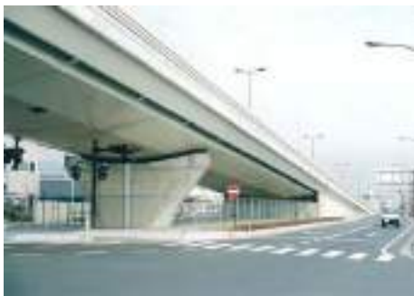
写真 5.7.5 側面及び桁下から見て軽快で明るい印象となるように、構造本体及び桁間ルーバー等が工夫されている。橋台に続く擁壁面を内側に追い込み圧迫感を軽減させ、桁との連続性も確保している。
