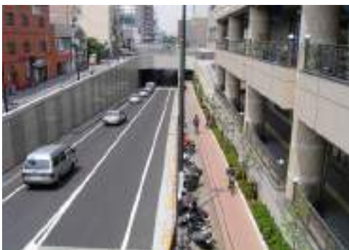
写真 5.4.5 再開発事業と同時に施工された鉄道アンダーパスは、歩道側をビル地下部分と接続させるとともに、公開空地に緑を配することで潤いを与えている。道路側壁面には吸音板を設置して騒音対策と景観配慮の両立を図っている。
