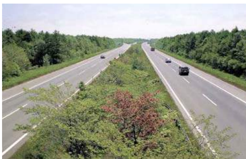
写真 4.3.4 中央分離帯に既存林を残しながら、平面分離することで良好な道路空間を創出している。
