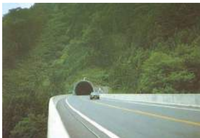
写真 1.8 鳴虫山の切土をトンネル構造としてことで、自然環境が見事に保全されている。
