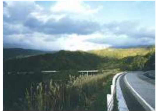
写真3.1.2 線形を地形にそわせるとともに谷の貫入部分は橋梁構造とすることで自然環境を保全している。
