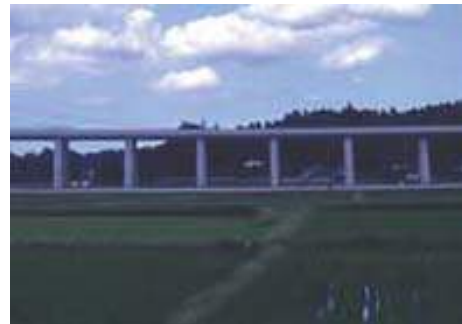
写真 3.4.2 シンプルなデザインの高架構造を採用したため、広がりのある田園景観が保全されている。
