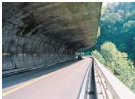
写真 5.4.10 片持ち式で内部、外部景観ともすっきりと自然におさめている。入口上部に後付けされた雪庇防止板に工夫が望まれる。
