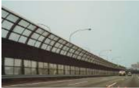
写真 5.10.3 ドライバーの視点付近と上空に、透光板を用いて道路内・外部景観とともに圧迫感の少ない遮音壁。
