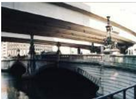
写真 4.4.12 高架橋のデザインの善し悪しにかかわらず、高架橋の存在そのものが地域の歴史や街の成り立ちを景観から感じ取ることが妨げている。
