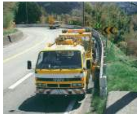
写真 6.1.2 防護柵の清掃
