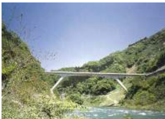
写真 5.3.45 深い溪谷に似合う方杖ラーメン橋。上路アーチ橋と同様に、視覚的な安定感がある。河川内に橋脚が立たないため、自然改変の印象が薄い。方杖部の下部工施工で極力地形や自然を改変しないように配慮する必要がある。
