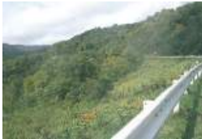
写真 5.2.6 人工的な盛土のり面を グレーディングと植 植生工によって周辺 の自然環境に馴染ませ せている。
