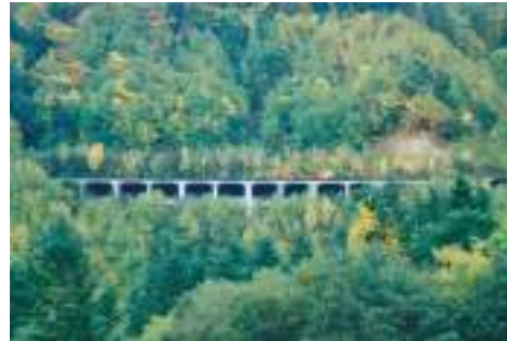
写真 5.4.9 自然に馴染むデザインとすることで、違和感のない外部景観と、快適な走行が確保されている。
