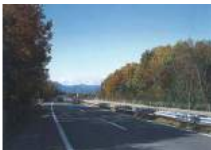
写真 1.13(上) 道路敷外の樹林を活用するために、樹林との橋渡しを果たす路傍植栽を行っている。
