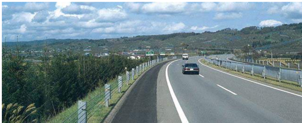
写真 3.2.3 なだらかな地形に沿った道路線形によって、地形の展開が意識できる開放的な走行景観が確保されている。
