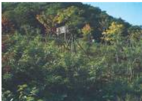
写真5.2.10 自生種による盛土のり面の全面的な緑化によって周辺の自然環境に馴染んだ復元がなされている。
