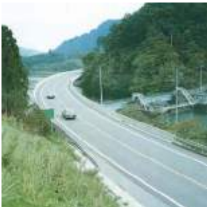
写真 1.5 鳴虫山の山麓に出現する切土を回避するため、線形を谷側に振り出している。
