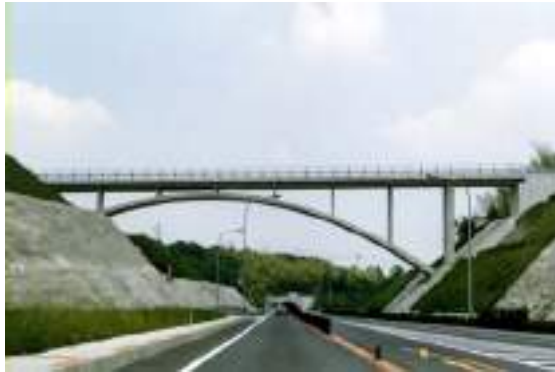
写真 5.13.3 オーバーブリッジ付近のみ完成形幅員で道路をつくり、前後の車線を片側に寄せて暫定開通すると、違和感を与える。
