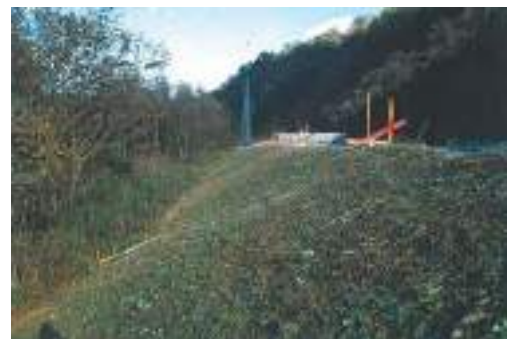
写真 1.10 盛土のり面を概成した後に表土を貼りつけている。
