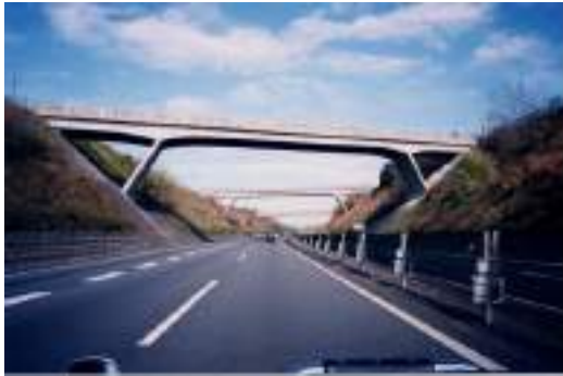
写真 5.3.1416 道路に対して斜角や縦断勾配があると、跨道橋とのり面で切り取られる道路空間がゆがみ、道路利用者に違和感を与える。
