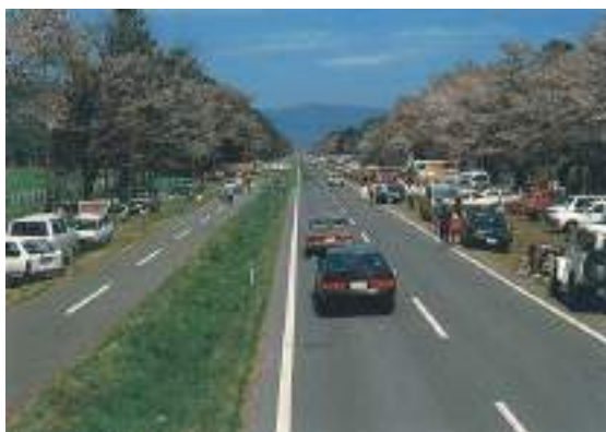
写真 5.11.8 ゆとりのある広い路肩が住民の憩いの場となり、地域に自生するエゾヤマザクラの植栽が花見の名所になっている。
