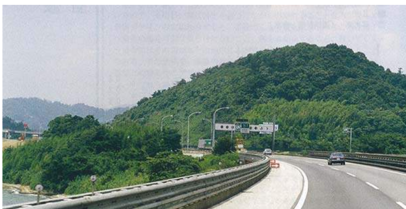
写真 5.2.3 地形によっては、のり面にわずかにラウンディングをすることによって、元々この形の山があったように見せることができる。
