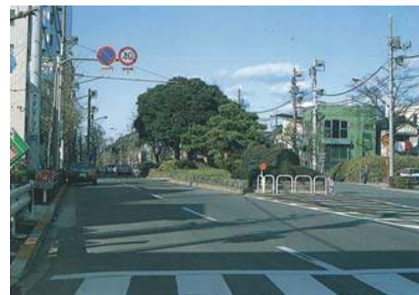
写真 5.11.18 史跡指定されている街道の一里塚を中央分離帯としてうまく保全している。
