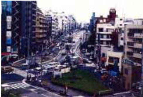
左側の旧道幅7.0mから右側に片側拡幅している途中。
