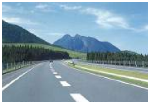
写真 3.2.1 滑らかで見通しの良い道路線形によって安全で快適な走行が確保されていると同時に、丘陵・高原地域の特徴的な印象を強調している。
