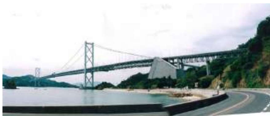
写真 5.3.89 その長大な適用支間から海岸地域などに用いられるため、その全貌が眺められる吊橋。構造と経済性の理由から基本的な側面シルエットはほぼ固定されるが、タワーの形態はデザインの余地が高い。一般に、ケーブルを支えるマッシブなアンカレッジが景観上の課題となるが、ここでは形状を三角形にデザインすることで力学的役割を表現するとともに、威圧感を減じている。
