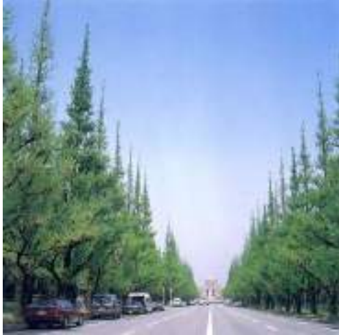
写真 4.4.1 真正面に絵画館を据えて格調の高い良好なビスタを構成している。4列のイチョウ並木の四季それぞれの美しさ、イチョウ並木の高さや車道幅のバランスが良いこと、2列のイチョウ並木に囲まれた歩道のゆとりある空間が確保されていることなどの理由によって、好ましい道路景観となっている。
