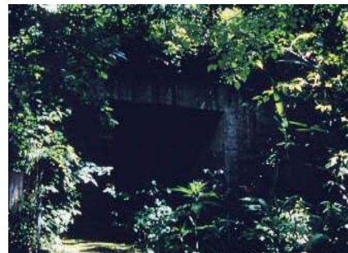
写真 1.19 上(整備当初)：カルバートボックスによってけもの道を確保している。 下：緑に覆われて人工的な印象が緩和されている。
