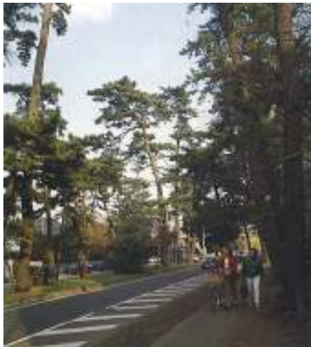
写真 5.11.17 道路の拡幅にあたり、上下線を分離して街道のマツ並木を保全している。
