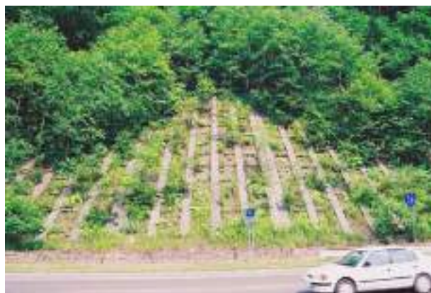
写真 5.2. 412 横フレームの印象を弱くすることにより、コンクリートのり面の視覚的印象に秩序を与えている。
