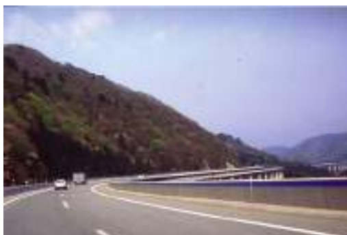
写真5.2.1 道路を高架構造にして山肌に沿わせた線形とすることで切盛土の出現をほとんどなくし、自然景観の改変を回避している。
