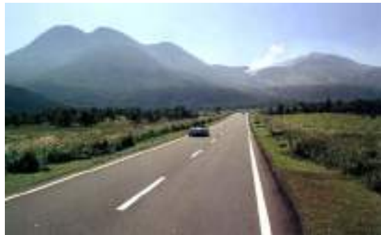
写真 4.2.2 前方の山とその噴煙を前方に見据え、高原地形を生かした路線を選んでいる。
