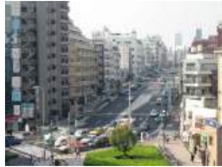
手前側は全幅30mに拡幅された。
