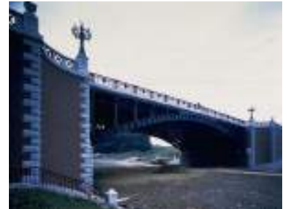
写真 5.15.3 移設されて長池見附橋となった旧四谷見附橋。旧橋を再利用して移設、修復活用されている。しかし周辺環境が大きく変化したためデザインの意味が損なわれた。やはり現位置での活用が望ましい。
