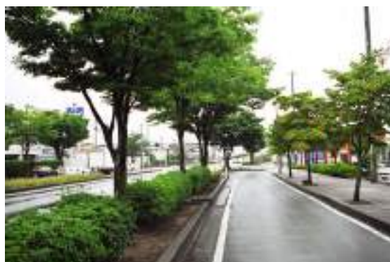
写真 4.4.9 副道を設置したゆとりある道路デザイン
