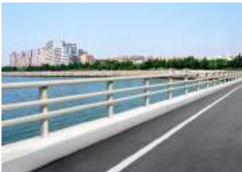
写真 5.10.1 シンプルで輝度彩度を下げた防護柵は、眺望を阻害せず、水辺の景色を引き立たせて開放的な走行景観を確保している。
