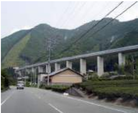
写真 5.13.1 シンプルな構造形式を採用したことですっきりした暫定形となっている。
