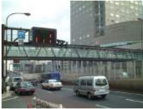
写真 5.3.1414 周辺建築物と調和した市街地内に建設された歩道橋。歩行空間をガラスで覆うことで、歩行者・道路利用者双方の安心感も演出している。
