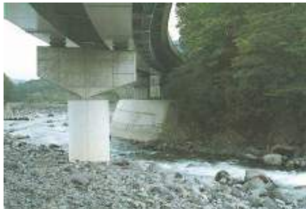
写真 1.5 鳴虫山の山麓に出現する切土を回避するため、線形を谷側に振り出している。
