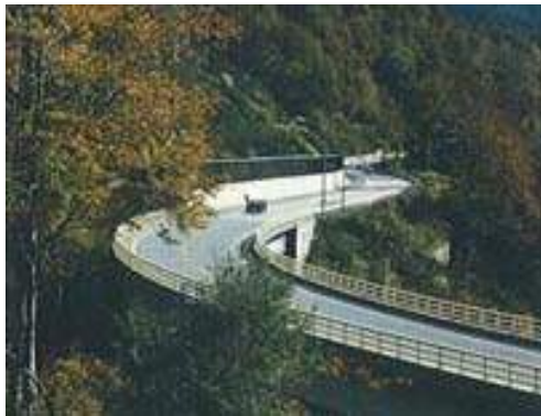
写真3.1.1 高架構造にして自然改変を縮小している。
