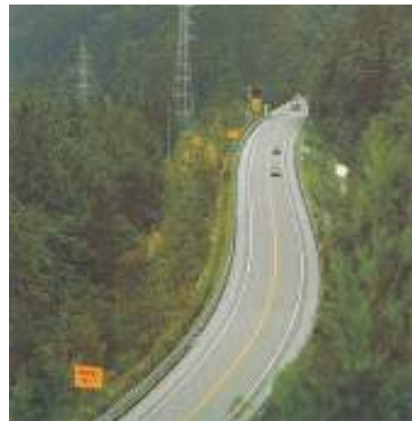
写真 3.1.3 自然環境及び景観を保全するために、谷側線形を振出し、縦断線形を下げ、大規模な地形の変更を回避している。
