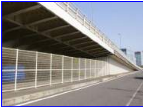
写真 5.3.4 都市内斜張橋の橋台事例。大規模な桁橋の橋台部処理事例としても引用できる。橋台・擁壁側面を 1m 程度内側に計画することで、上部工の地覆・高欄が形づくるフェイスラインを、地盤までスムーズに連続させている。段差下部に水切りを設けることで、壁側面の汚れは少ない。
