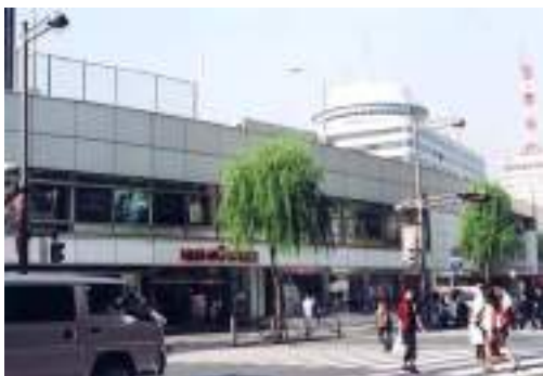
写真 4.6.1 計画当初から高架橋と建築物を一体的に考えている。都市内高速道路の下に店舗を建設することで、街並みはすっきりとする。
