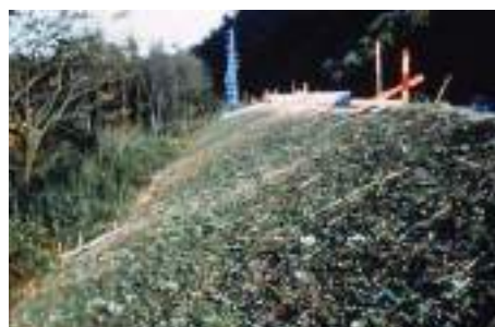
写真 5.11.16 地域の自然環境を復元するために表土を貼りつけている。
