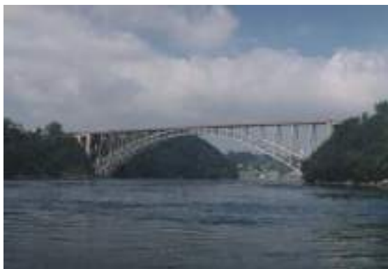
写真 5.3.1 アーチ橋を採用したことにより、自然の改変が抑えられる。また、美しいスパンドルアーチ形式の採用により、豊かな自然景観との調和と海峡部の適度なゲート性の表現が両立されている。
