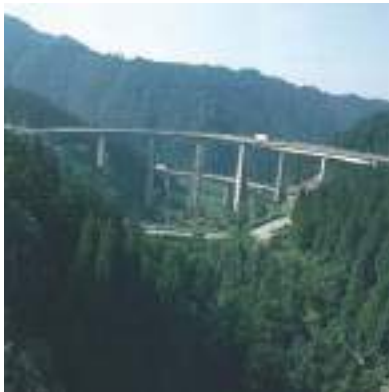
写真 5.3.9 10 ループ橋を採用したことで、周辺の自然環境の改変が極力抑えられ、景観的におさまっている。
