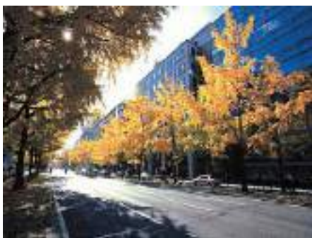
写真 4.4.13 沿道建物と高さや壁面線位置が統一された道路。銀杏並木とともに連続性のあるデザインとなっている。
