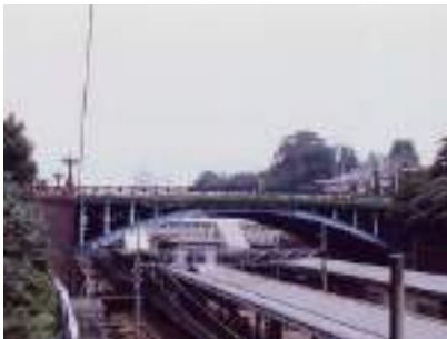
写真 5.15.1 移設前の四谷見附橋。 近隣の迎賓館（旧赤坂離宮）のデザインと呼応した照明柱や高欄が用いられた。
