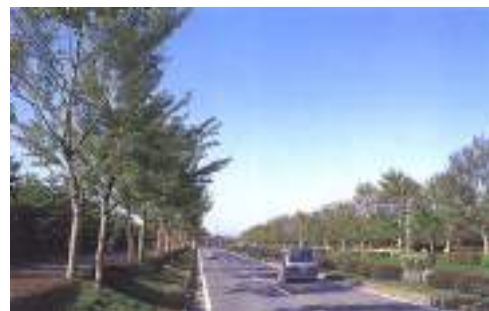
写真 4.3.5 歩行者自転車道と車道をわずかに高低分離して、安心してゆとりのある空間を歩行者、自転車に与えている。
