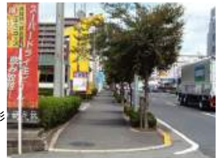
写真 3.5.2 沿道要素の景観的影響を緩和するには、歩道部が狭すぎる。
