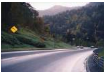
写真 5.2.7 切土のり面を地形と 馴染む緩やかな勾配 で造成(グレーディ ング)し、自生種が 侵入しやすく、速 やかな環境復元が なされ、地域景観 との調和を図って いる。
