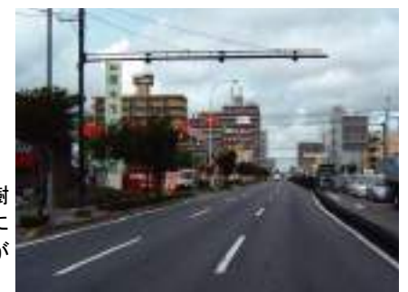
写真 3.5.3 道路の規格と街路樹とのアンバランスにより景観的な遮断がなされていない。
