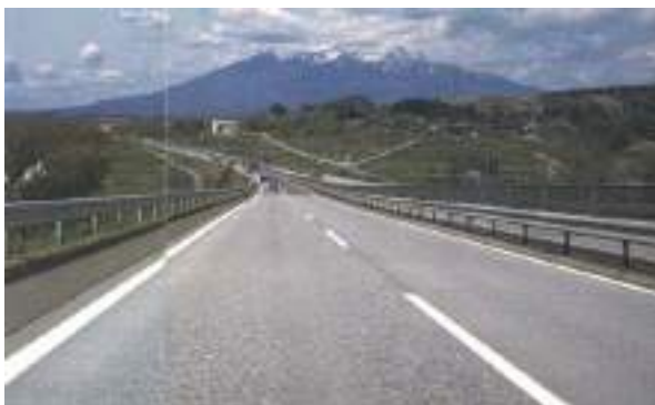
写真 3.2.4 山アテする線形を採用して、山を大きく見せる演出を行い、地域の認識を印象的にしている。
