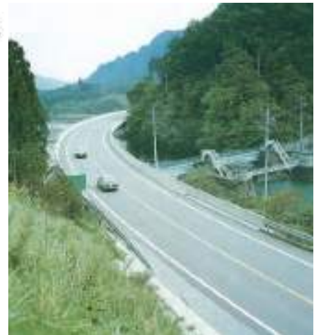
写真 3.1.4 計画段階では掘削まで検討せず、のり面は出現しなかったが、設計段階で橋脚の掘削を検討すると 3 段の切土が生じたため、道路線形を谷側へ振出して切土の出現を回避している。
