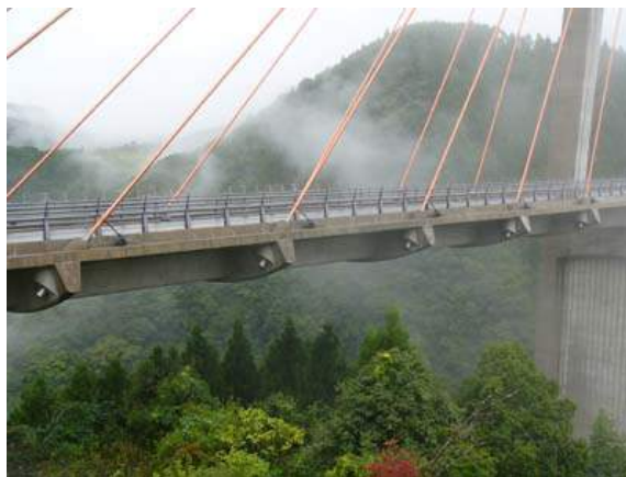
写真 5.3.3 力学的機能を明快に形に表すデザイン方針で設計された橋であるが、ケーブル定着部やそれを支える横桁等の形状等細部のデザインにもデザイナーの目配りが行き届いている。
