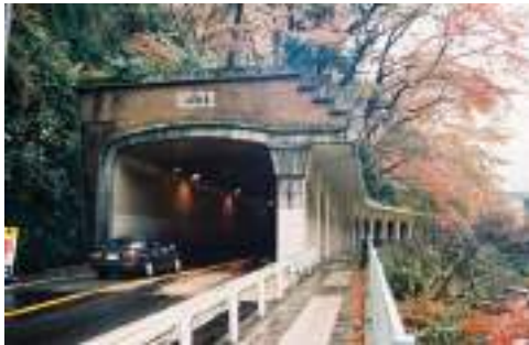
写真 5.4.8 自然に馴染む趣のあるデザインとすることで、路線のランドマークとなっている。狭いながらも、歩道が覆道の柱を境に車道と分離され、安心して散策することができる。
