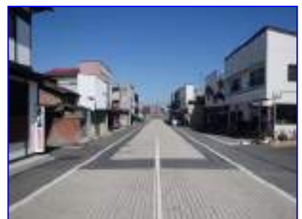
写真 5.5.2 歩車共存道路において、車道中央部のみをブロック舗装として、視覚的な速度抑制のデバイスとしている。
