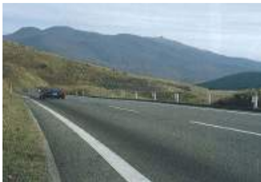
写真 3.1.5 地形のひだに合わせた線形設計により、地形の変化ある展開によってもたらされる地域景観が内部景観に取込まれている。
