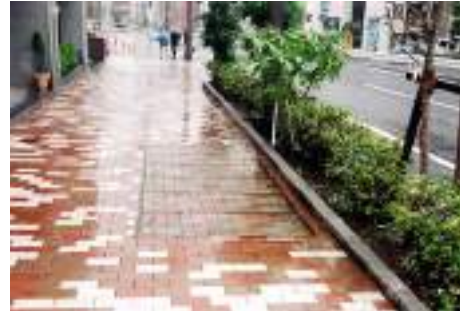
無電柱化で歩道がすっきりとしたが、舗装の明細度が高すぎて落ち着きがない。
