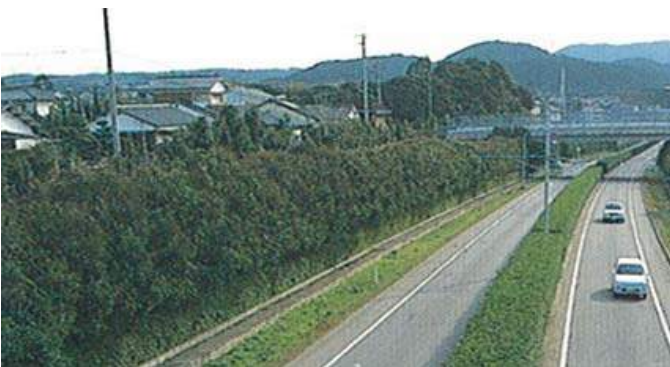
写真 3.5.1 隣接する生活環境を保全するための切土の植樹帯とゆとりのある道路構造により良好な内部外部景観となっている。
