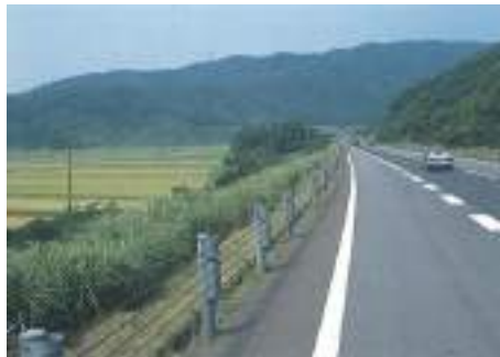
写真 3.4.1 線形とガードケーブルの採用とが相まって、田園地帯の空間の広がりがよく見通せ、遠方の山並みを強調したダイナミックな内部景観が得られている。
