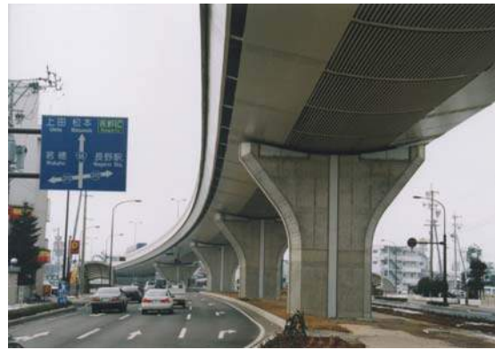
写真 5.13.2 張出し部の先端にブラケットを新たに設置して車線を両側に継ぎ足す構造で、完成時への対応を可能にし、暫定・完成時の両方の景観に十分な配慮がなされている。
