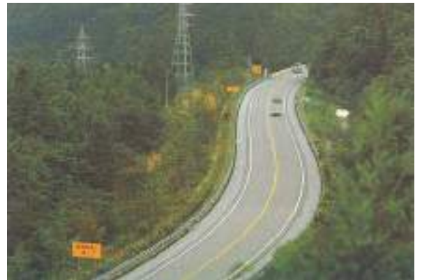
写真 1.6 線形の平面的ないし縦断的移动によって、のり面を最小化している。
