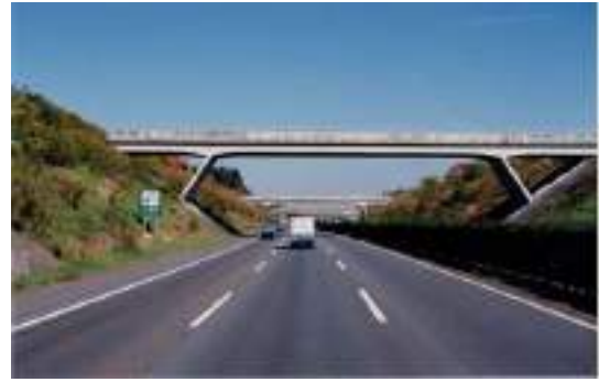
写真 5.3.1415 道路に対して直角で水平に配置された跨道橋が連続すると、規則正しい統一感が生まれる。
