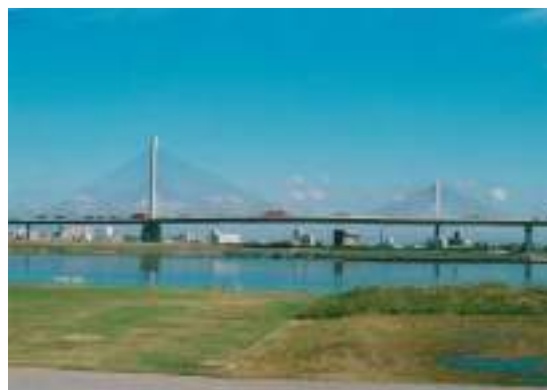
写真 5.3.78 起伏のない広大な河川景観にあって印象的な幾何学形態の斜張橋。人は簡素でまとまりのある形に対して良い印象を抱く。都市的でシャープな印象だが、煩雑な都市景観の中では往々にして景観を乱すので、選択時には注意を要する。
