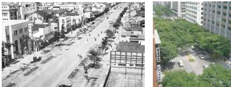
写真 2.3 ゆとりある道路幅員が確保された青葉通 整備当初(左)と現在(右)
