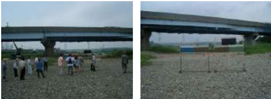
写真 5.12.1 橋梁の色彩検討の様子。大型色見本を現地に持ち込み、周辺景観との関係を確認しながら色彩を最終決定することが最も確実な検討手法である。
