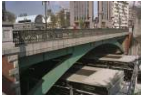
写真 5.15.2 交通量の増大に伴い架け替えられた四谷見附橋。アーチに近いラーメン形式とし、付属物のデザインも継承された。
