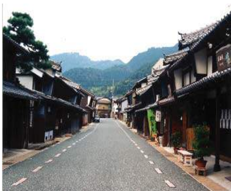
写真 3.6.2 伝統的な街並みのたたずまいを損なわず、道路をシンプルに整備している。
