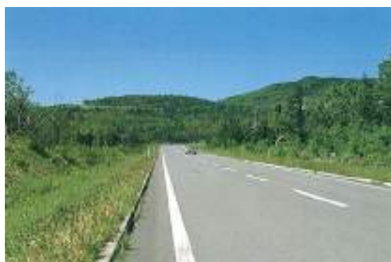
写真 3.2.7 地形に沿わせた路線選定と線形設計により豊かな自然環境とゆとりのある走行景観が保全されている。
