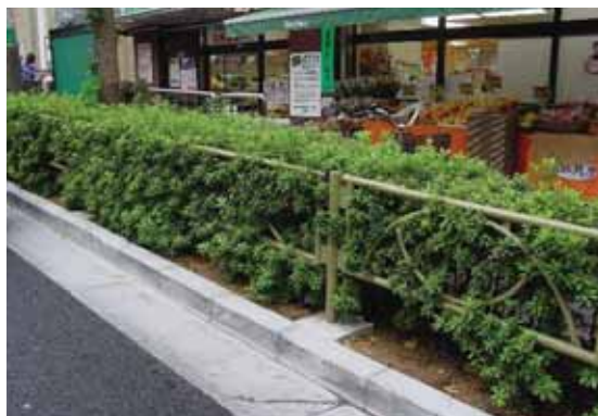
■植樹帯と横断防止柵とが併用されている例 この場合、横断防止柵設置の必要性はない
