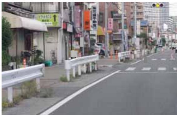
■ 沿道出入口を確保するため細切れに設置されている車両用防護柵の例 必ずしも車両用防護柵である必要はなく、ボラード等による代替が可能である
