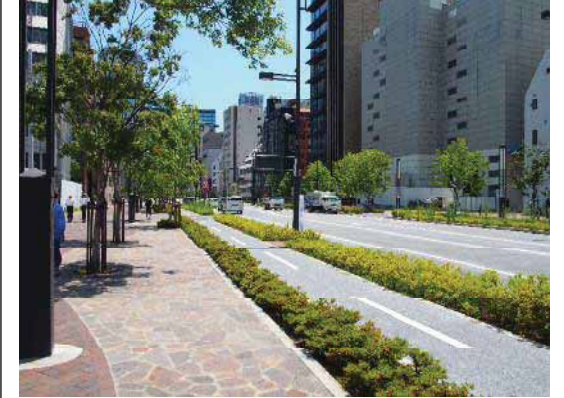
■歩道内への自転車道の設置において、視覚的な変化とともに、自転車の走行性にも配慮された舗装材の選定された例
