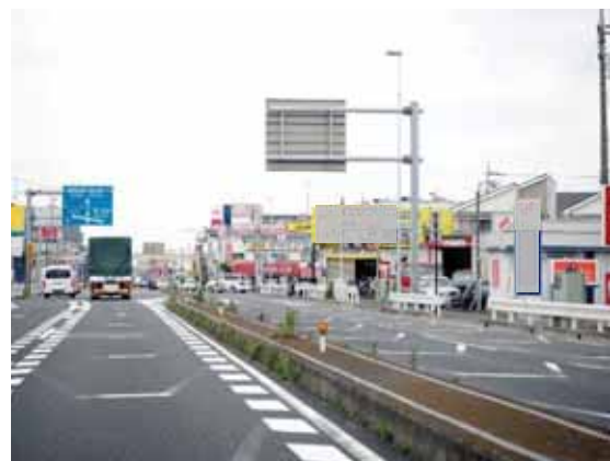
■郊外部の道路では、沿道への出入りによって断続的となる防護柵等や、様々な素材・色彩の道路附属物等が出現し、道路景観が煩雑になりやすい
