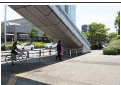
■ パイプ柵を用いて立入防止を図っている例
