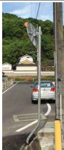
■支柱や鏡面の取付枠の背面に垂鉛めっき仕上げを採用 している例 周辺環境との調和を目的に橙色以外の色を採用
