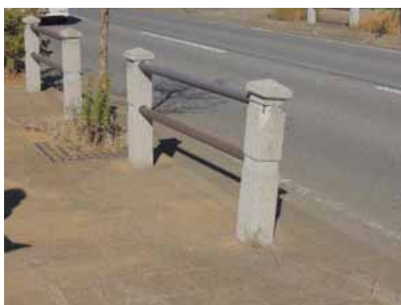
■ 防護柵に御影石を併用した例 防護柵の変形や破損に際し、迅速な修繕・復旧が難しい
