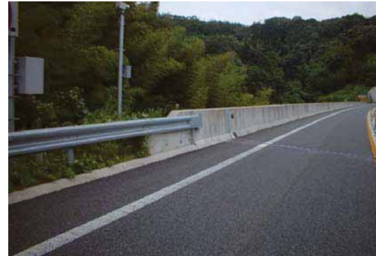
■たわみ性防護柵と剛性防護柵との接合部の連続性を確保している
