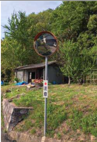
■支柱や鏡面の取付枠の背面に垂鉛めっき仕上げを採用 している例 周辺環境との調和を目的に橙色以外の色を採用
