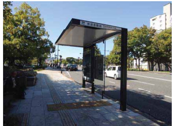
■民間企業による維持管理を導入し道路景観 を保全しているバス停上屋の例
