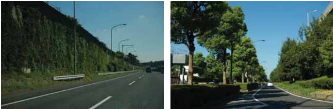
■植栽により遮音壁を隠している例（左写真：前面に植栽、右写真：背面に植栽）
