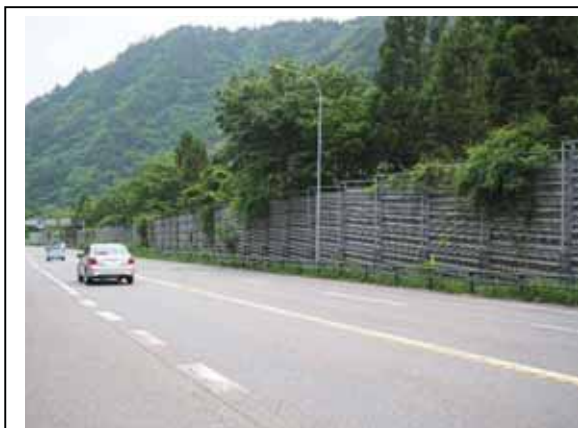
■ 収納していない防雪柵の例 目立たない色彩を採用している
