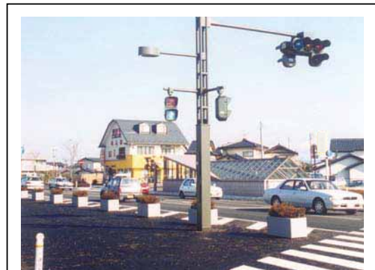
■暫定供用時において、プランターを設置し、車両の誘導を行っている例
