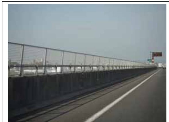
■透過性の高い落下物防止柵により圧迫感を軽減している例
