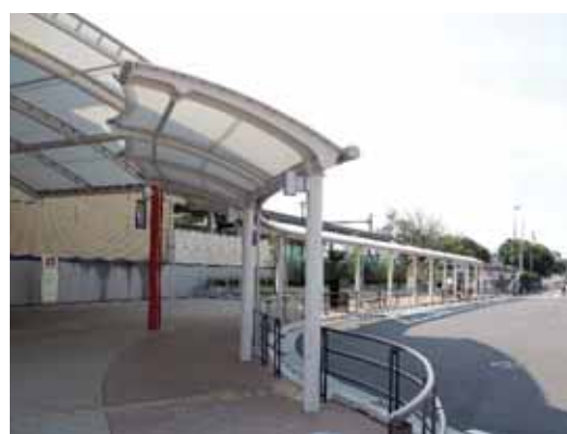
■道路附属物として整備された駅前広場のバス停上屋の例 照明柱、横断防止柵、ポラードをダークグレーで統一するなかで、連続するバス停上屋に透過性のある素材を用いるとともに、全体をオフホワイトでまとめて明るい空間を確保している
