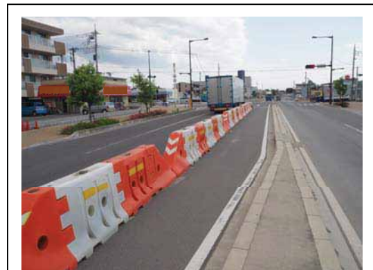
■仮設の防護柵が目立ちすぎている例
