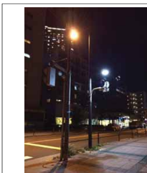
■灯具と道路附属物等が近接した例 共架する道路附属物等と灯具の離隔が小さい場合は、不適切な影が路面に落ちる標識の視認性が低下する可能性がある
