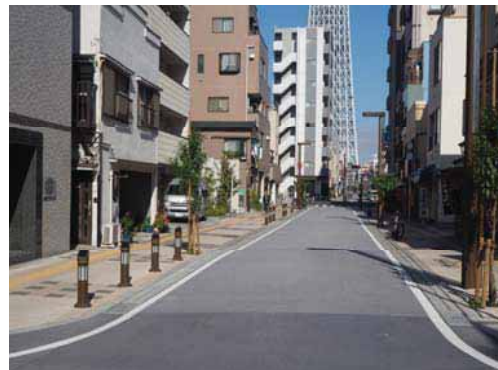
■ シンプルな形状のボラードを歩車道境界に設置している例 沿道出入口により防護柵が断続的になる場合はボラードも有効な選択肢の一つである
