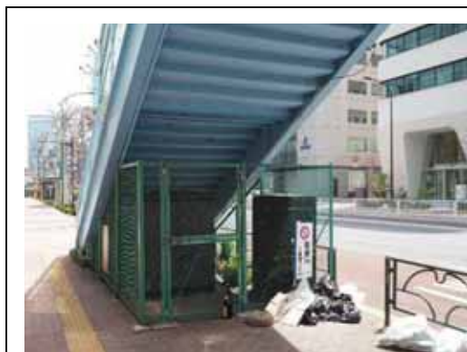
■ 歩道橋下に無造作に設置された緑色の立入防止柵
