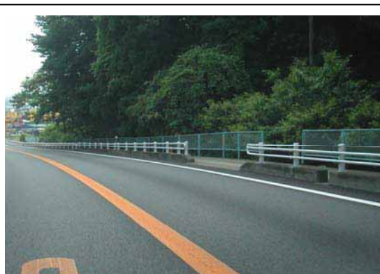
■車両用防護柵(歩車道境界)と転落防止柵(歩道路側)の色彩が異なり、景観的な調和が感じられない
