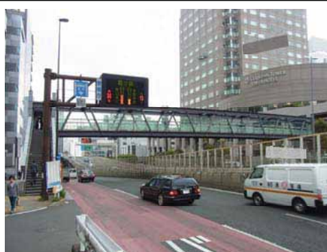
■透過性の高いトラス橋の歩道橋
