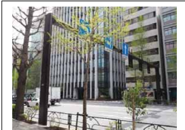
■門型標識柱の支柱断面を、道路縦断方向で確保することにより、道路進行方向の景観阻害を軽減できている
