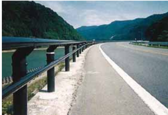
■上下線で異なる形式、色彩の防護柵とすると、アンバランスな印象となる
