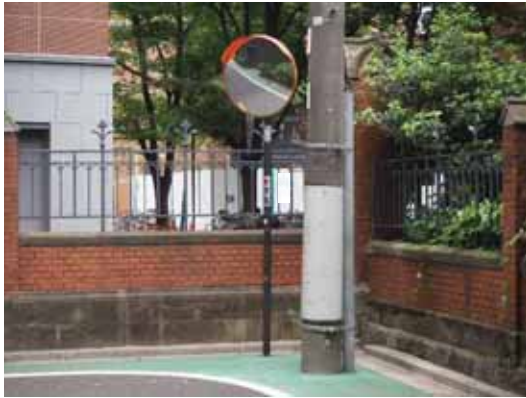
■ダークブラウンの支柱を採用した例 道路反射鏡の存在が視認されやすい立地では、 背後の建物等との景観調和と交通安全機能との 両立が可能な場合がある
