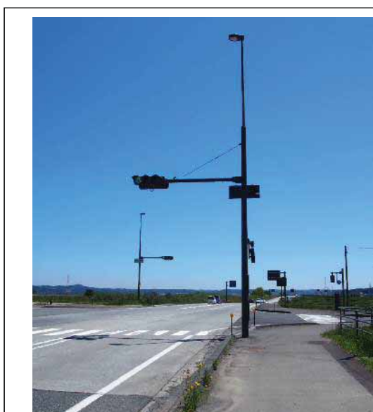
■信号機と照明を一体化した例 交差点内の道路附属物等が集約され、すっきりとした印象を与える
