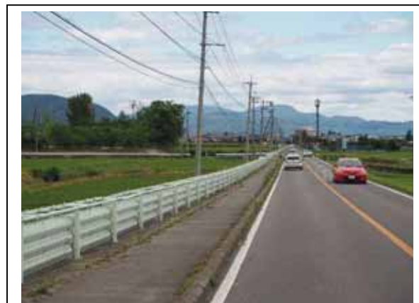
■ たたんだ状態の防雪柵の例 収納時には柵による圧迫感が軽減される
