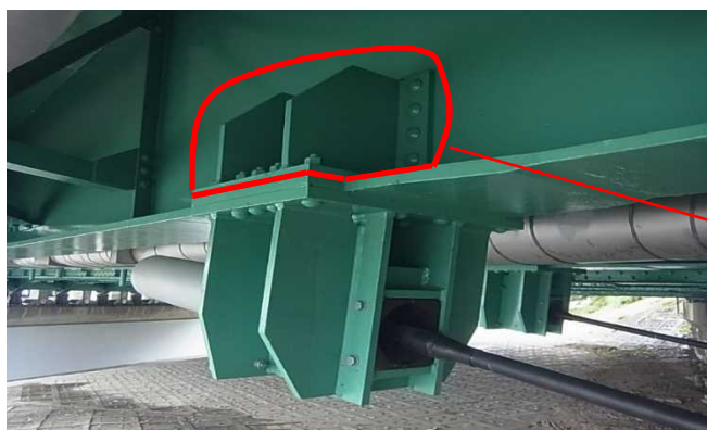
写真Ⅲ－1：勸進橋に用いられた製品の引張試験部材
