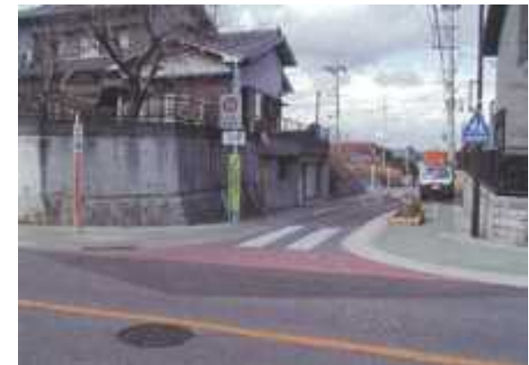
交差点狭窄の例 (歩道張り出しによる狭窄)
