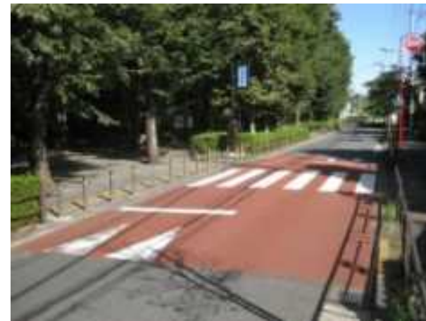
スムーズ横断歩道 (横断歩道部分が凸部となっている)
