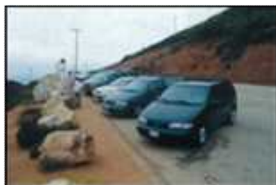
沿道駐車帯の整備
