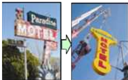
看板の改修・撤去
