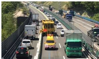
<移動式防護柵による車線切替>
