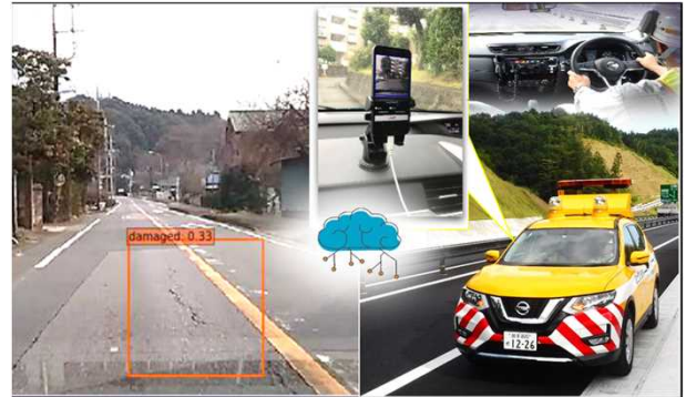
パトロール車両に搭載したカメラからのリアルタイム映像をAI技術により処理し、舗装の損傷を自動検知
