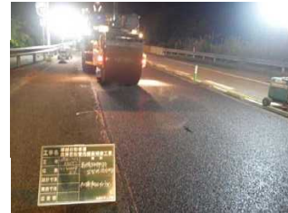
暫定2車線区間での夜間通行止による舗装工事 (磐越道 会津坂下～津川)
