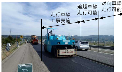
走行車線規制により工事实施 対向車線は規制なし
