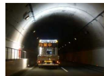
▲覆工コンクリート表面撮影 高精度デジタルビデオカメラにより、高速走行で撮影し、覆工のひび割れ等を調査
