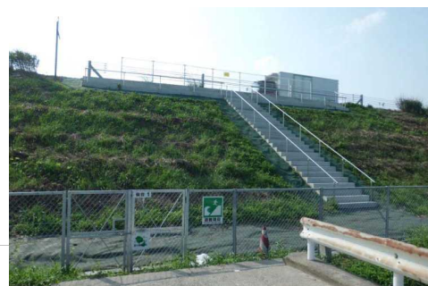
▲津波避難階段(仙台東部道路)
