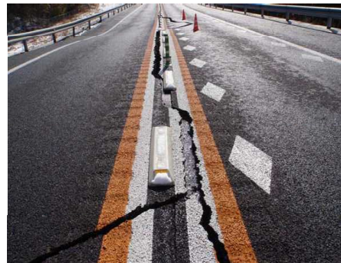
片側交互通行により緊急交通路確保
