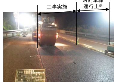
夜間通行止により工事实施
