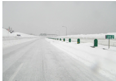
4車線区間(北陸道 上越JCT～上越)
