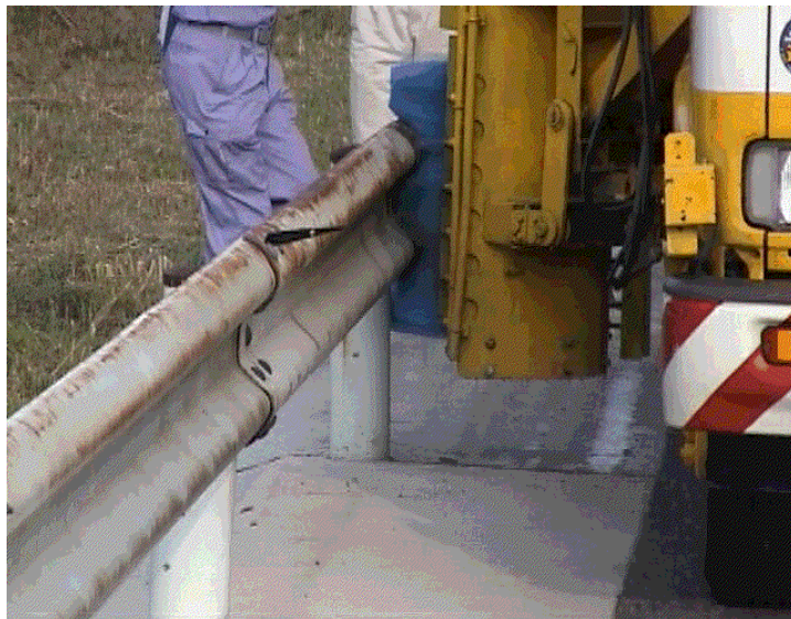
ガードレール清掃中の状況
