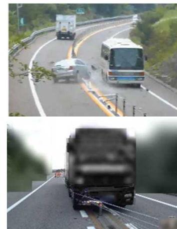
ワイヤロープの 対向車線飛出し防止状況
