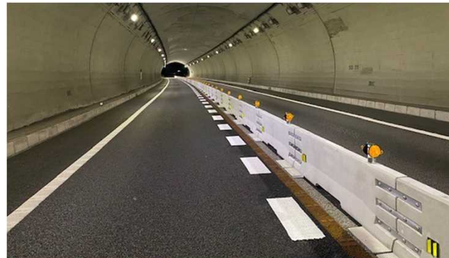
C3 東海環状道 栢洞トンネル
