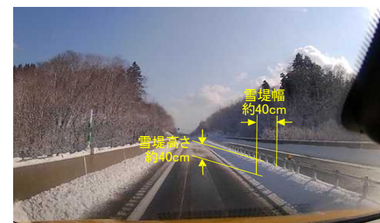
センターパイプ区間
