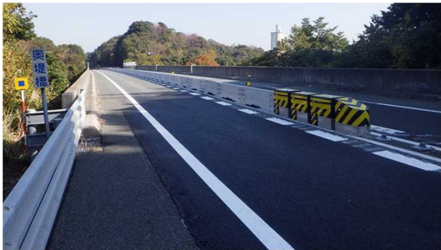
E2 山陽道 宇部下関線 奥堤橋
