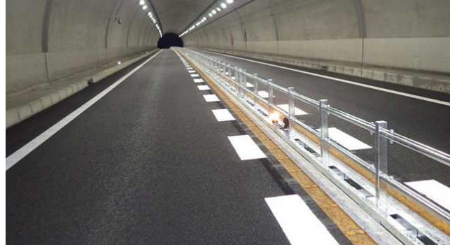
E10 東九州道 今仁トンネル
