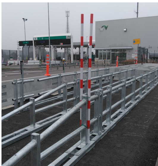
【センターパイプ】
