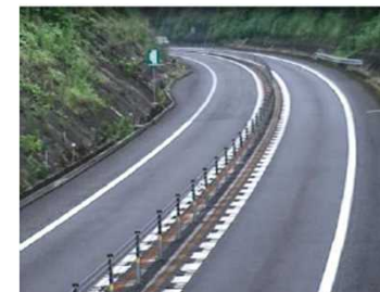
突破箇所状況(復旧後)
