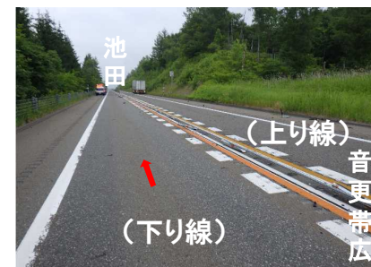
突破事故発生箇所
