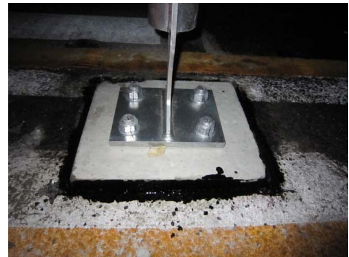
⑥防水工施工
