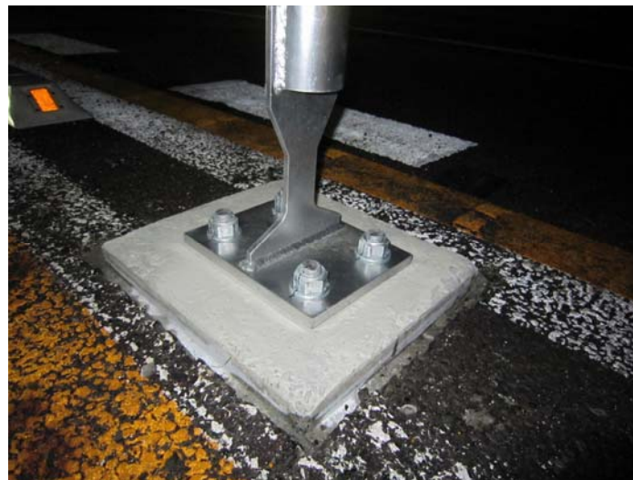
⑤支柱設置・ワイヤロープ設置
