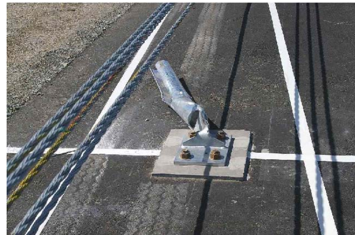
性能確認試験後の支柱とコンクリート基礎定着部の状況
