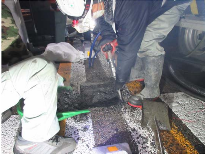
①舗装撤去
