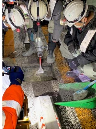
②床版防水工撤去
