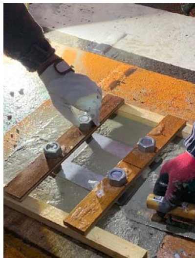
④コンクリート打設・アンカー設置
