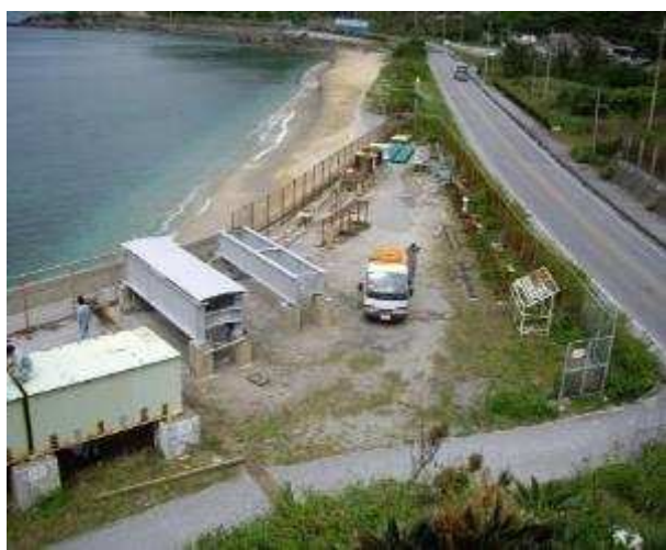
沖縄・大宜味村、土木研究所 沖縄建設材料耐久性試験施設
