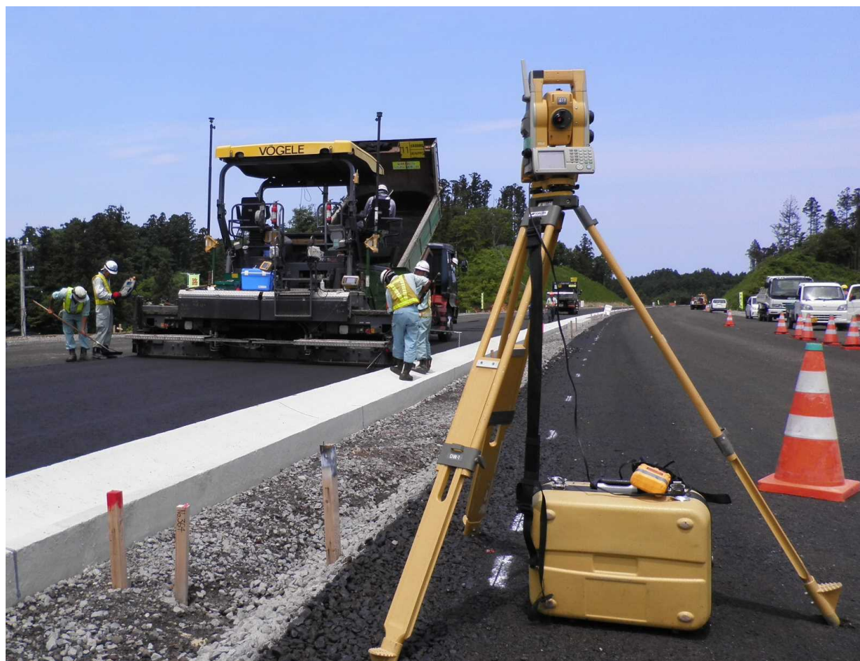
【写真－1】ICT舗装の施工状況
