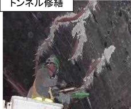
ひび割れ注入による補修
