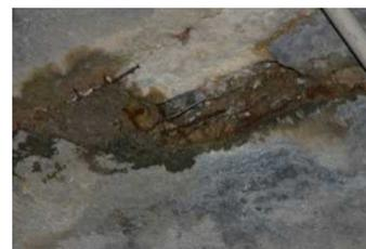
覆工コンクリートの剥落・貫通ひびわれ
