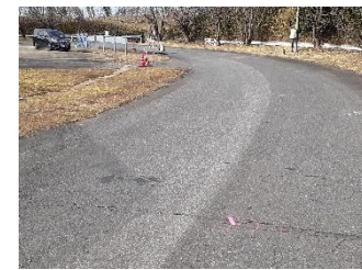
実道(土研内道路)での検証[道路巡視]
