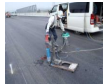
コア採取による舗装の密度管理
