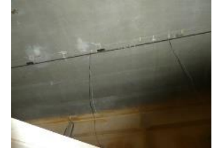
光ファイバによる橋梁モニタリング
