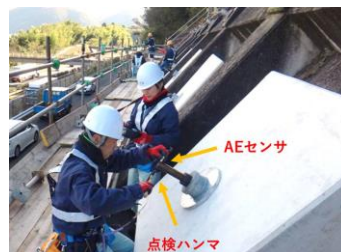
打音検査状況
