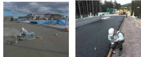
砂置換法による路盤の密度管理 温度計による転圧温度測定
