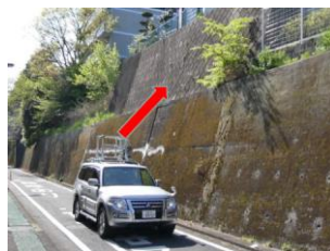
MMSIによる計測状況
