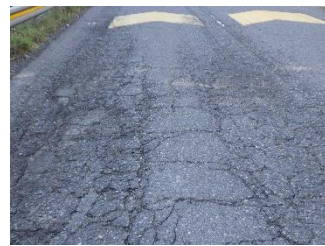
実道(国道1号)での検証[舗装点検]
