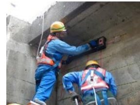
非破壊検査による鋼材の破断の検出
