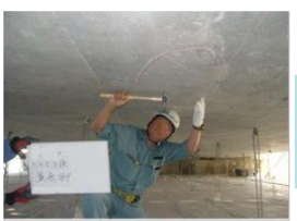
直轄定期点検
