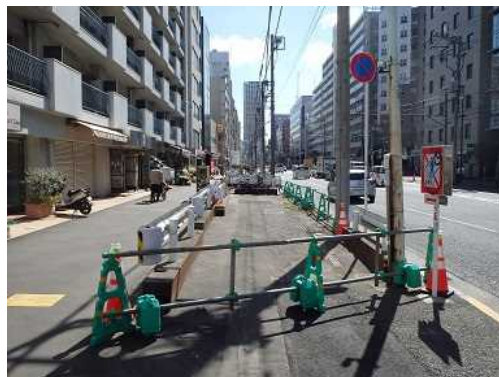
上目黒（環状6号線） 電線共同溝工事より
