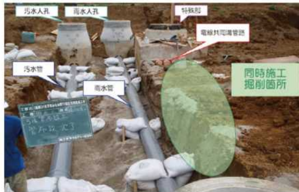
③下水・ガス・水道・NTT・CATV・電力管路部の埋戻
