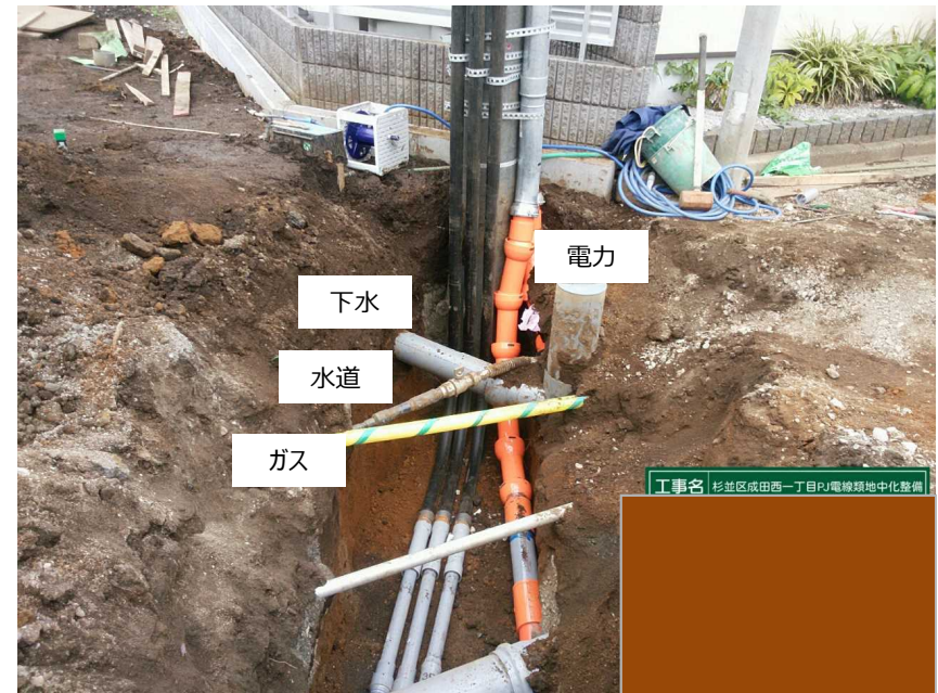
22年10月11日～10月25日（電力・通信工事）
