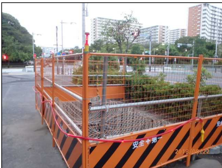
港湾局大井2号電線共同溝工事より
