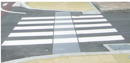
写真Ⅱ-12 横断歩道におけるエスコートゾーンの設置例
