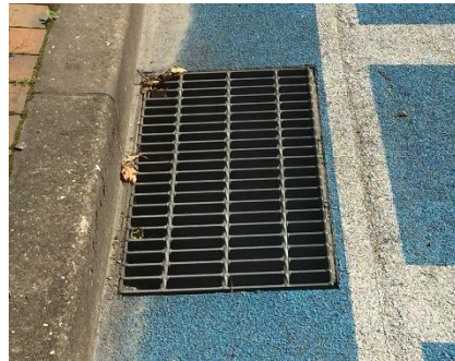
写真Ⅱ-3 グレーチング蓋の格子の形状等を工夫した事例
