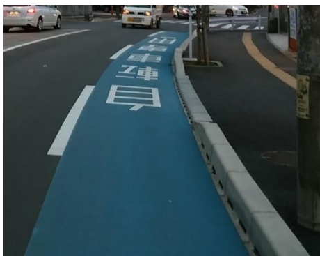
写真Ⅱ-1 エプロンの幅が狭く平坦性の高い街渠に置き換えた事例
