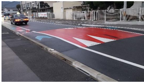
写真Ⅱ-10 車道部分にハンプを設置した事例
