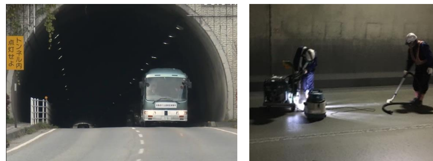
磁気マーカ埋設の施工状況（2日間で施工）
