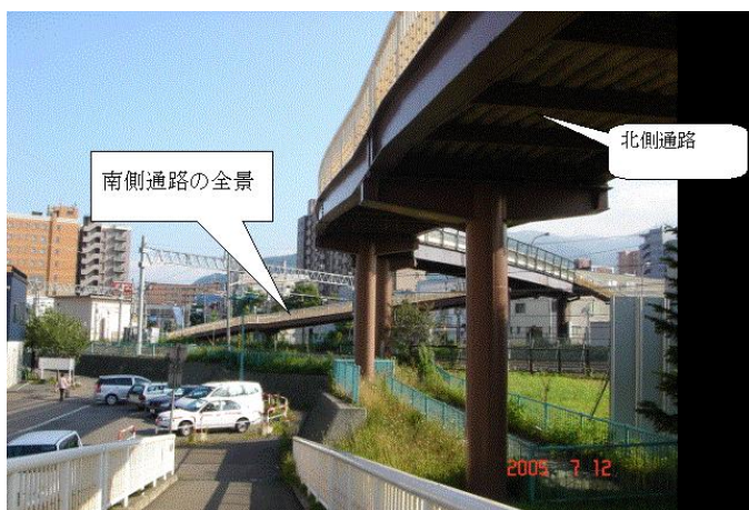
樽川人道跨線橋 全景写真（北側通路より）
