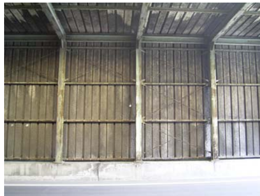
壁面（3号トンネル吹付状況）
