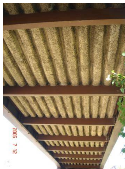
上： 北側通路（吹付状況）
