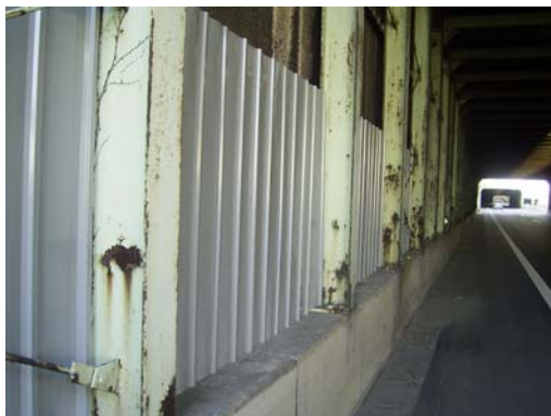
応急対策状況（3号トンネル）
