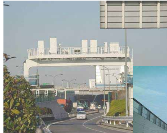
湾岸線(西行)東扇島出口(1車線)
