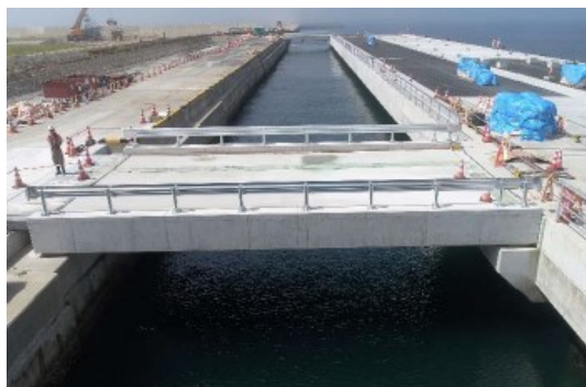
渡橋の架設状況
