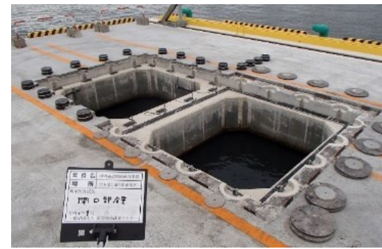
施工性確認試験実施状況(床版撤去)
