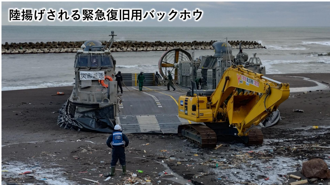
緊急復旧用の砕石等を荷積みしたダンプトラック
